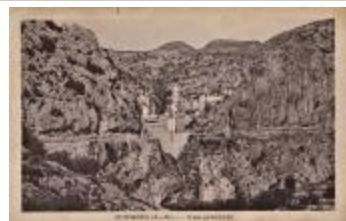
Cuébris (A.-M.). - Vue générale (06052-IM-00911)
