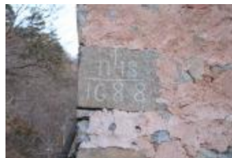
Maison surélevée - hameau de Saint-Pierre - Millésime : "IHS 1688" (06094-IM-00216)
