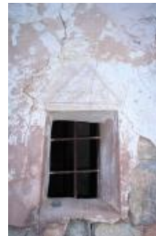
Chapelle Saint-Pierre détail décor plâtre gravé Fenêtre droite (06094-IM-00229)
