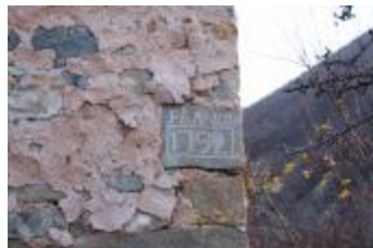
Maison surélevée - hameau de Saint-Pierre - Millésime : "François 1792" (06094-IM- 00214)
