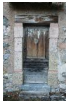
Détail architecture : Porte avec encadrement en pierre taillée de tuff et brique - hameau de Saint-Pierre (06094-IM-00220)
