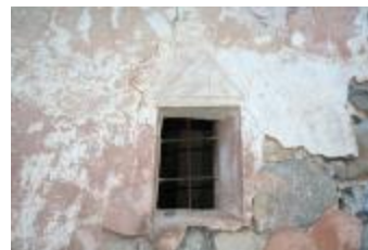
Fenêtre droite - Chapelle Saint-Pierre (06094-IM-00227)
