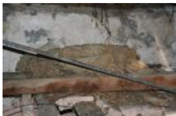
Détail architecture : construction voûte - hameau de Saint-Pierre - détail de bât souple (06094-IM-00209)
