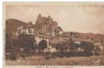
Péone (A.-M.), Alt. 950 m - Vue générale (06094-IM-00203)
