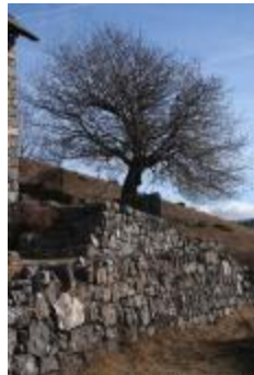
Détail escalier de la ferme de La Sagne (06094-IM-00238)
