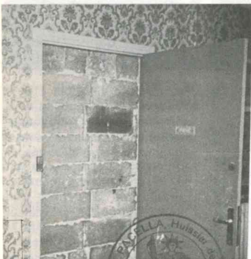
vue de la salle de séjour, mur entièrement construit
